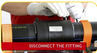
No fim do ciclo de resfriamento, remover o alinhador e iniciar o teste sob pressão utilizando a unidade para testes sob pressão.
