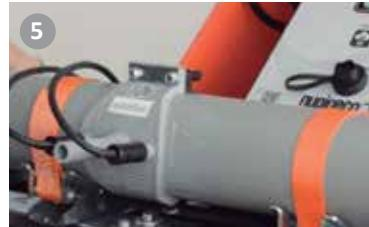
Ligar os dois fios da máquina de electrocolagem aos conectores do colarinho eletrosoldável e seguir o procedimento habitual de soldadura dos acessórios eletrosoldáveis. Os parâmetros de tempo e tensão são sempre definidos no código de barras no colarinho.
