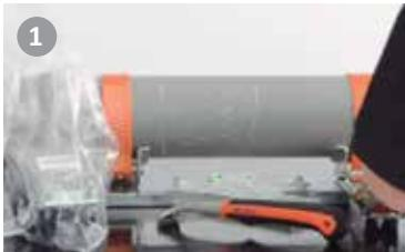
Medir o comprimento do acessório e marcar a área de soldadura com um marcador. Raspar cuidadosamente a superfície da tubagem com um raspador.
