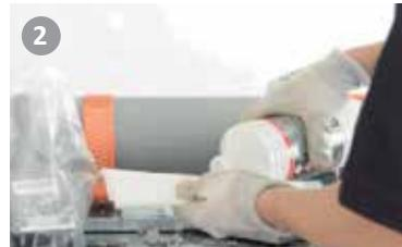
Depois de raspar, remover a sujidade e a gordura da zona de soldadura do tubo e do interior do assento do colarinho, utilizando um agente de limpeza adequado. Esperar até que as peças limpas estejam completamente secas.
