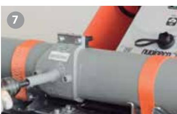
Proceder à perfuração da tubagem com uma broca ou elemento de perfuração adequado, verificando se o diâmetro da broca e o comprimento são compatíveis com o interior da tubagem principal e da ramificação.
